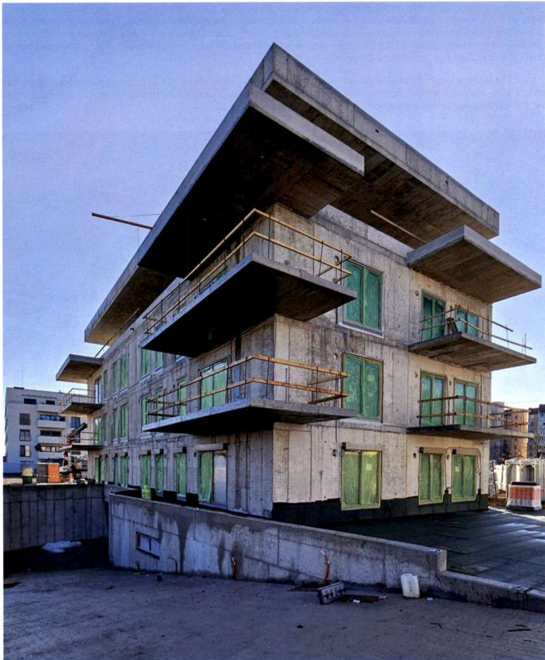
Slika 9. Dokončana AB konstrukcija z vgrajenim stavbnim pohištvom
