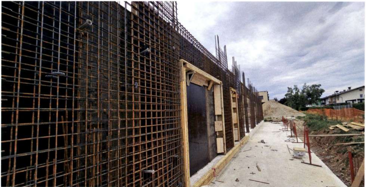
Slika 7. Izvedba sten pritličja
