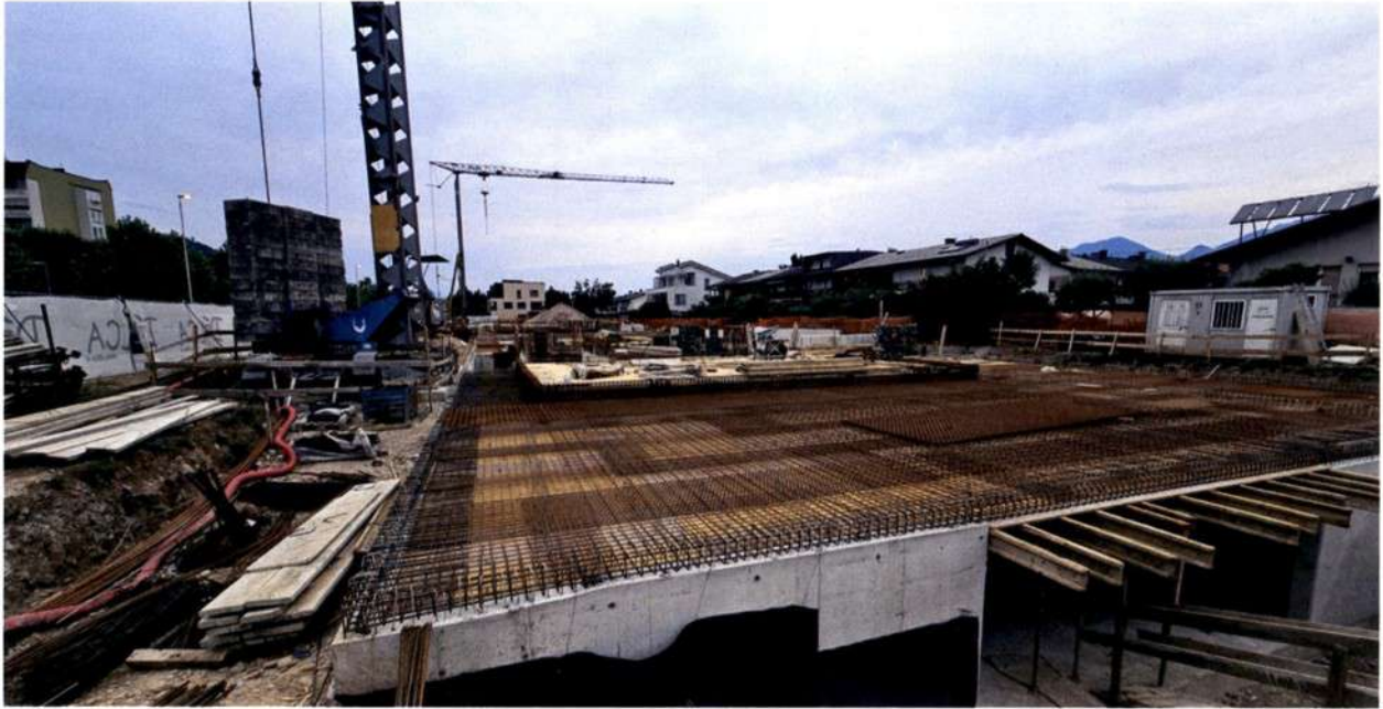
Slika 6. Izvedba plošče nad kletjo
