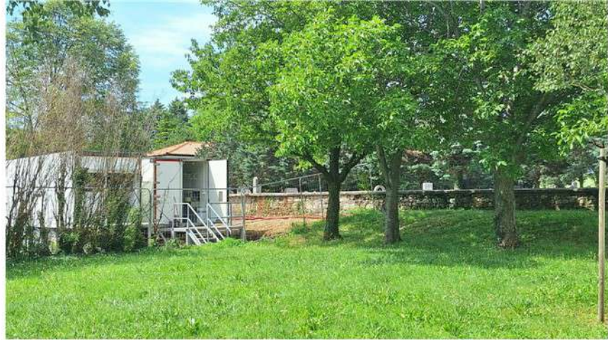
Na gradbišču objekta Rezidenca Lokavška dela že potekajo. Foto: Radio Koper
