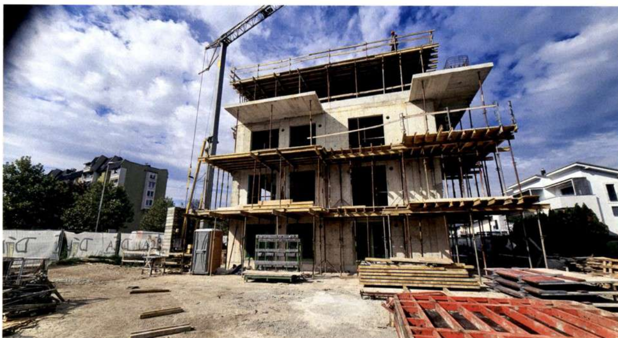
Slika 8. Pogled na lamelo B med gradnjo
