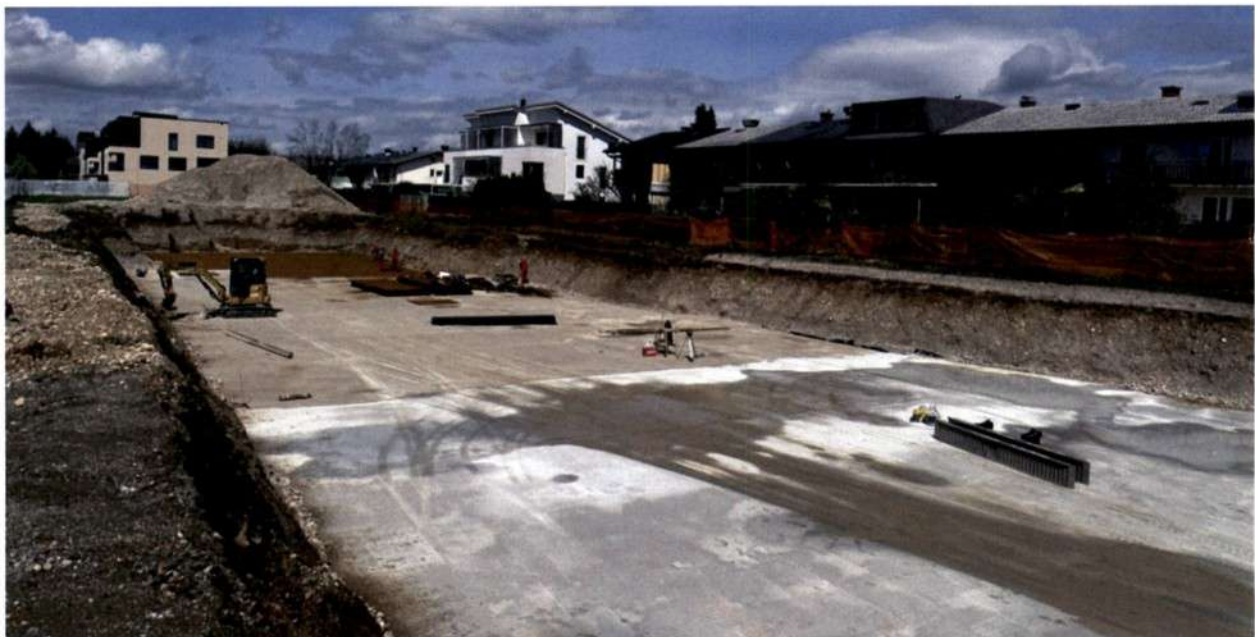
Slika 3. Priprava temeljne plošče
