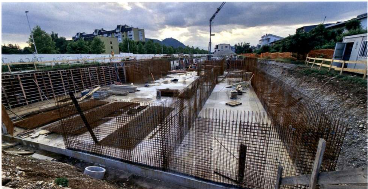
Slika 5. Izvedba kletne etaže
