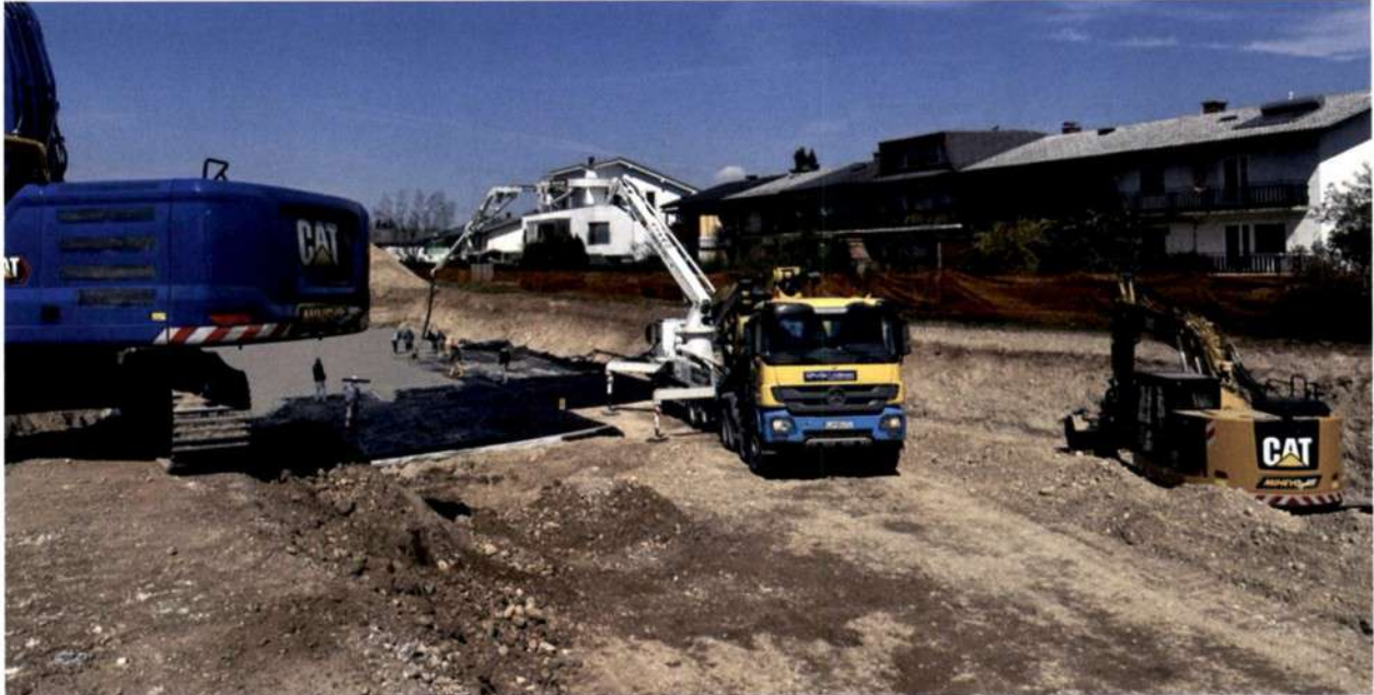
Slika 2. Začetna faza gradnje z izkopi, pripravo terena in podložnim betonom
